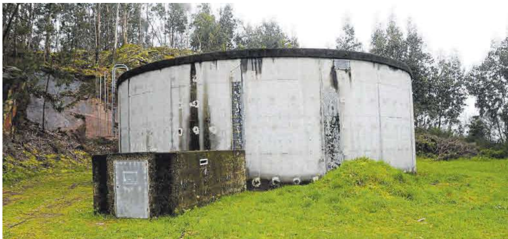
Depósito de agua en O Hío.
